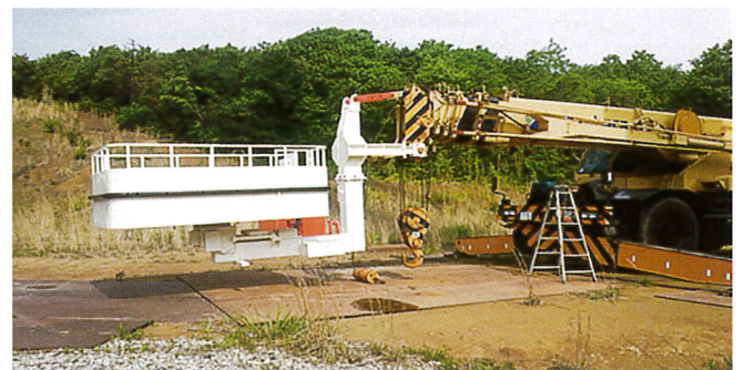
SS-300 50Tラフター取付
